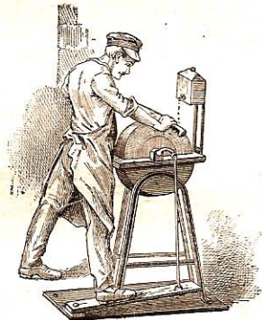
Fig. 133. — El pedal del amolador, palanca de tercer género.
