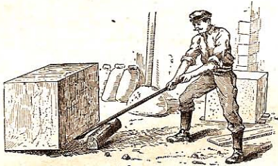
Fig. 131. — La alzaprima del albañil, palanca de primer género.
